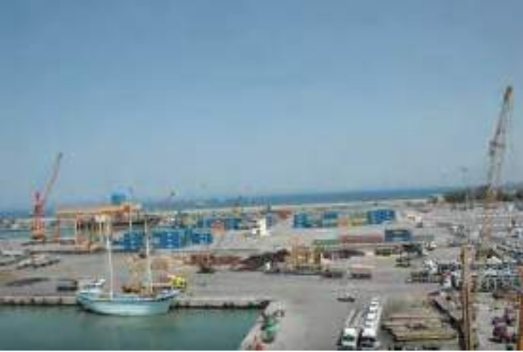
الصورة (١٢) ميناء اللاذقية
